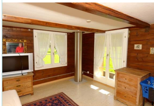
Der Kamin wurde mit einer Chromstahl-Ummantelung auf Wunsch des Kunden vom OG bis über's Dach gezogen.
