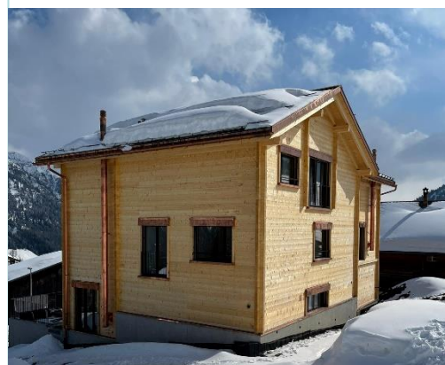
Aufnahme des Gebäudes, mit dem neuen Fassadenkamin von Luzi Kaminbau, Küblis
