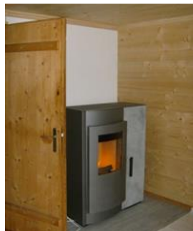
Der «Induo» brennt im Pelletmodus und heizt während der Abwesenheit sowie über Nacht. Abends wird der Ofen mit Holz eingeheizt.
