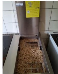
Pellet-Tank ca. 20 Kg Fassungsvermögen
